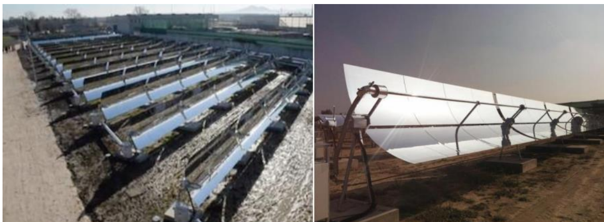
Рисунок 4 - Фото солнечной тепловой станции и деталь параболического желоба (справа)
